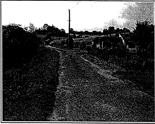
Chaussée véhiculant les eaux de ruissellement sur la commune de Cys-la-Commune (Source : DDE 02/SRPR/PR)
